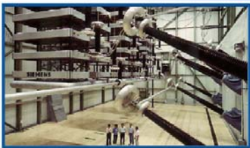
Abb. 2: Ventilgruppe HVDC classic für 500 kV/ 600 MW (Quelle: Siemens)
