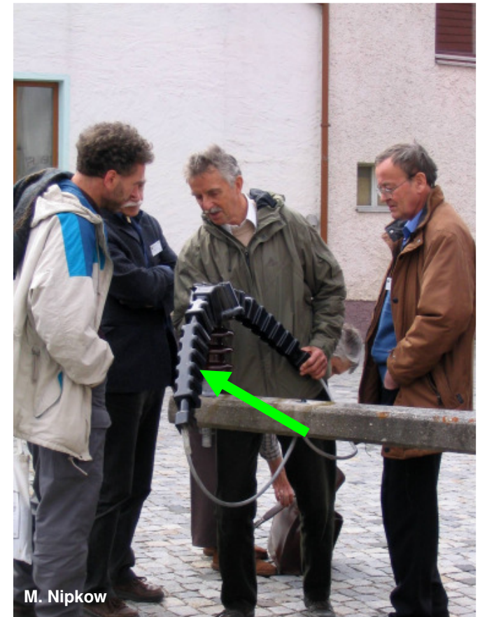
Abdeckhaube zur Entschärfung eines Masts mit Stützerisolatoren
