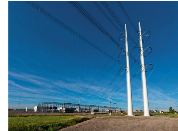
Der niederländische Netzbetreiber TenneT entwickelte neuartige Mast- und Leitungskonstruktionen, die elektromagnetische Felder reduzieren. Die ersten Wintrack-Masten wurden im Sommer 2010 errichtet.
