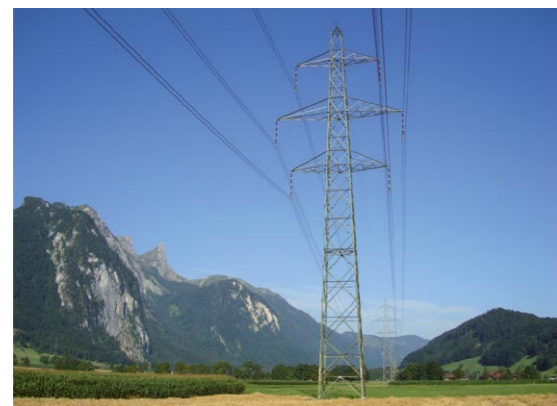
In der gebirgigen Schweizer Landschaft ist die Planung von Höchstspannungsleitungen besonders anspruchsvoll. Die Behörden testen neue Beurteilungsverfahren an ausgewählten Strecken.
