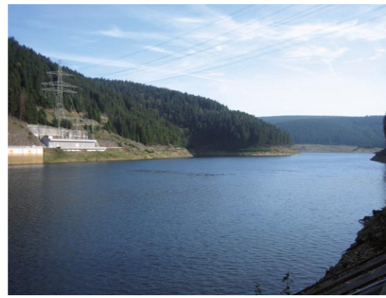
Pumpspeicherkraftwerke wie Goldisthal im Thüringer Wald können zum Ausgleich der Erneuerbaren Energien beitragen.
