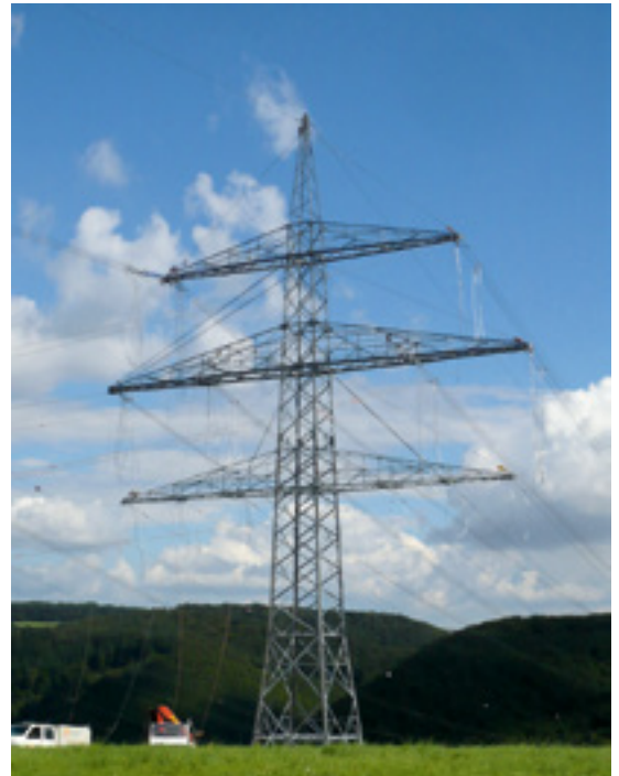
Abb. 1 Errichtung einer neuen 380-kV-Leitung im Amprion-Netzgebiet, Foto: DUH/N. Schrader
