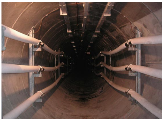
Abb. 2 380-kV-Kabel Berlin-Friedrichshain/Marzahn, Tunnelvariante, Foto: DUH/R. Hänlein
