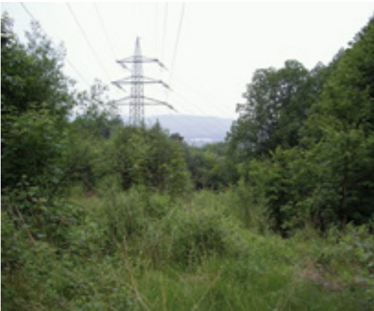
Werden niedrige Gehölze unter der Leitung zugelassen, ist die zerschneidende Wirkung der Trasse nicht mehr so stark. Beispiel: Ökologisches Trassenmanagement in Rheinland-Pfalz; Foto: L. Becker / DUH
